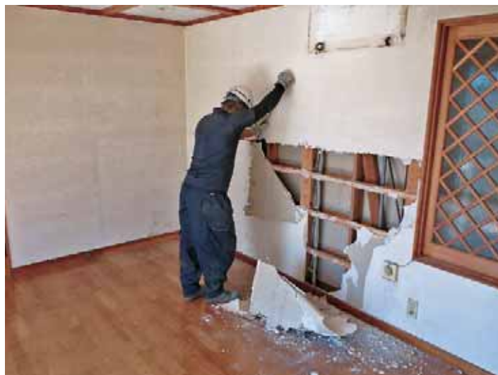
内装ボード撤去
