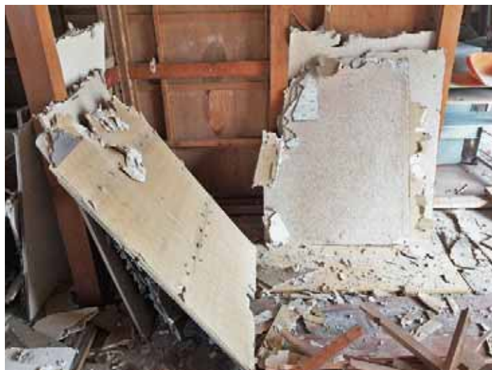
内装ボード撤去
