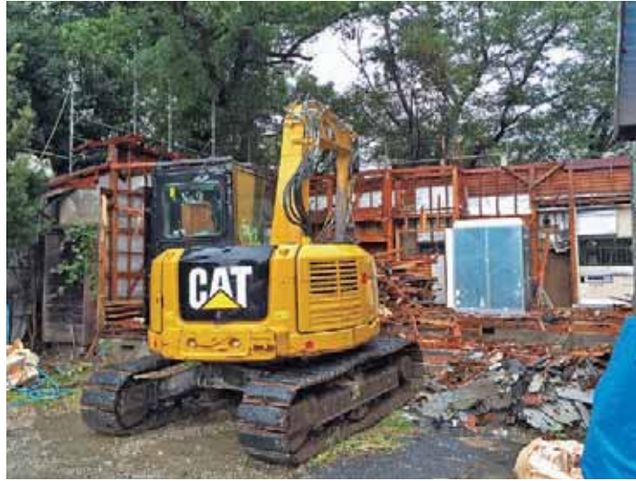
木造上屋解体
