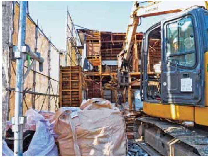
木造上屋解体
