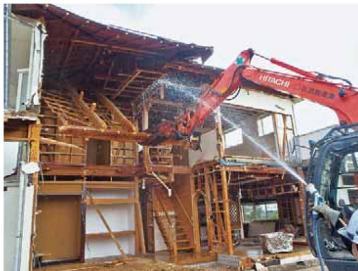
木造上屋解体
